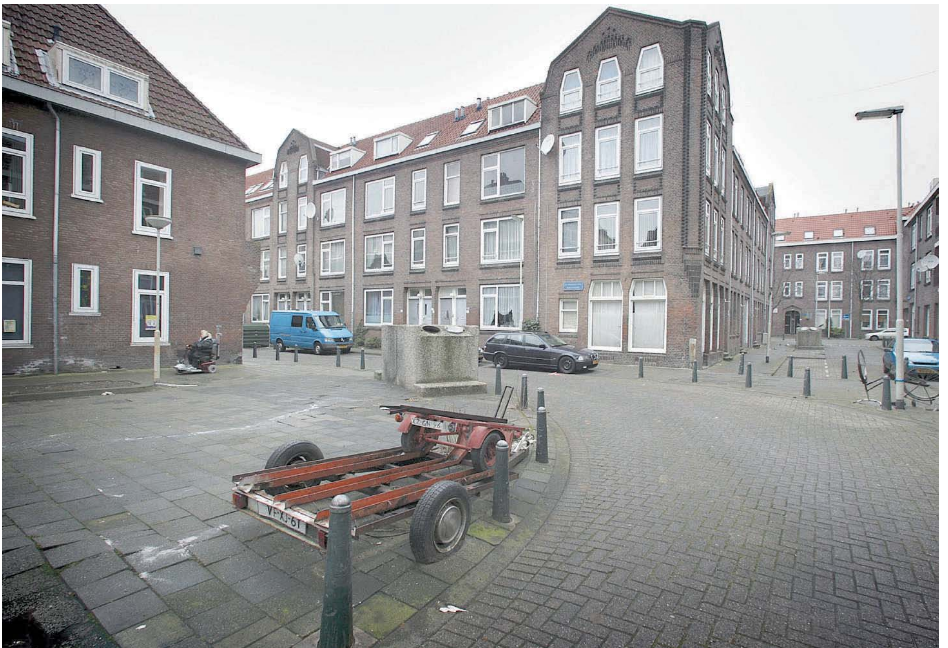
Deze woningen in de Rotterdamse wijk Nieuw Crooswijk zullen tussen 2006 en 2015 verdwijnen. (foto NRC Handelsblad, Rien Zilvold)
